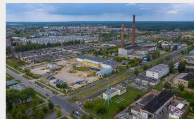
DAUGAVPILS PILSĒTAS ZIEMEĻU RŪPNIECISKĀS ZONAS PUBLISKĀS INFRASTRUKTŪRAS ATTĪSTĪBA, III KĀRTA
