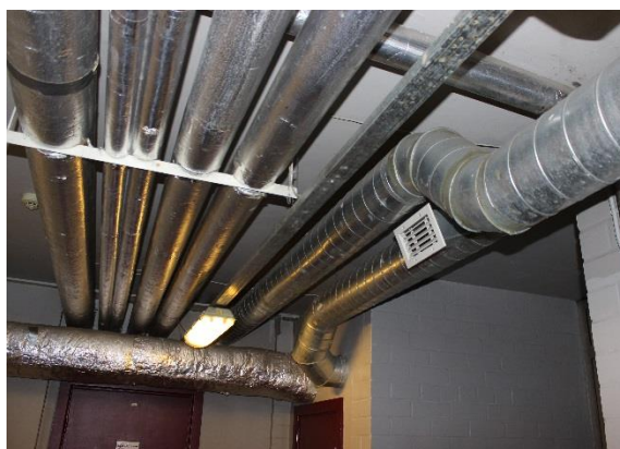
Ventilācija telpa zem tribīnes bez rekuperācijas
