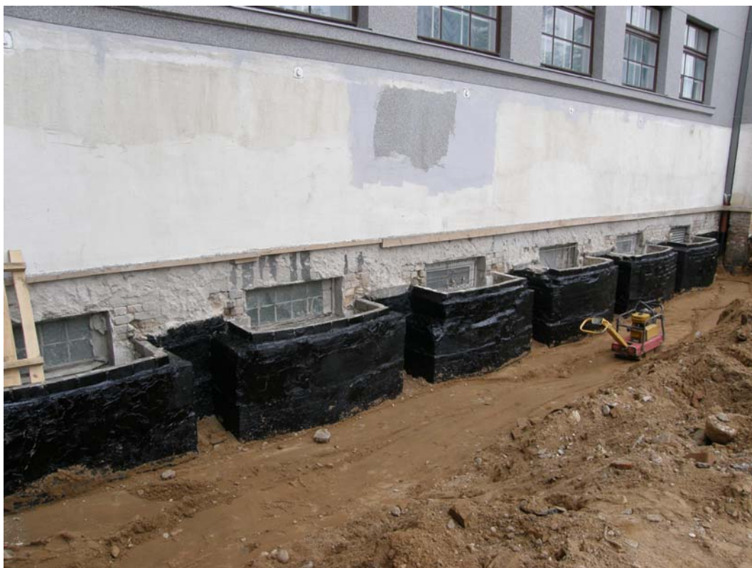
Atjaunota ēkas pamatņu un logu padziļinājumu hidroizolācija
