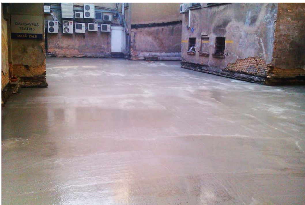
Atjaunots iekšējā pagalmiņa pārsegums: betonēšanas darbi.
