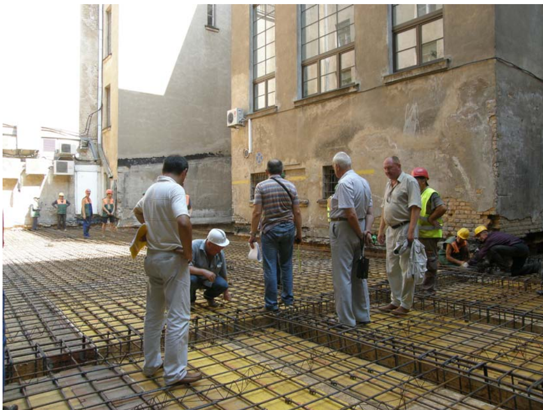
Atjaunots iekšējā pagalmiņa pārsegums: armēšanas darbi
