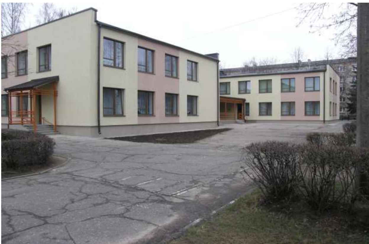
Daugavpils pirmsskolas izglītības iestāde Nr.17, Stadiona ielā 6, pēc renovācijas darbiem
