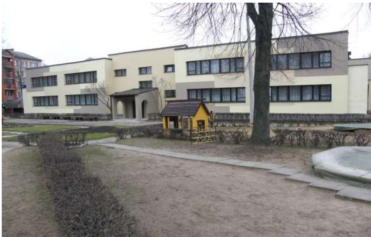
Daugavpils pirmsskolas izglītības iestāde Nr.14, Vienības ielā 36A, pēc renovācijas darbiem
