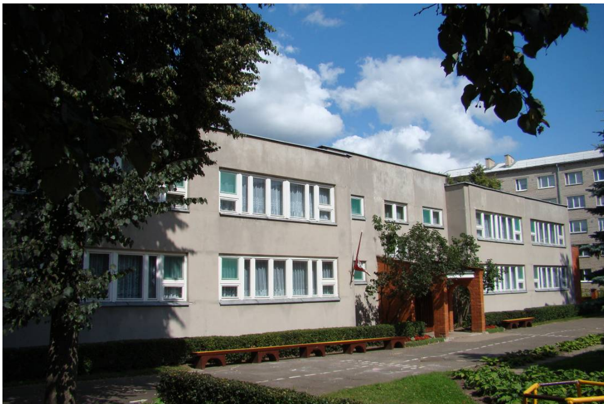
Attēls Nr.2 Ēka Nr.2 Vienības ielā 36A, Daugavpils, bērnudārzs Nr.14
