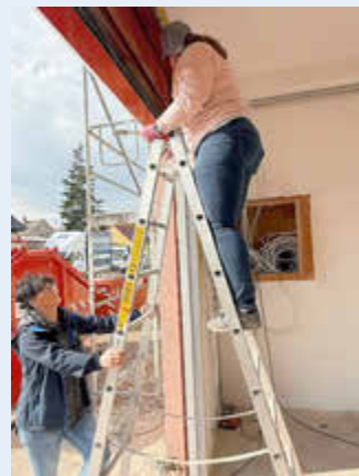
Eine Woche lang wurde in Göttnitz gearbeitet und alle haben mit angepackt.
