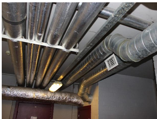
Ventilācija telpa zem tribīnes bez rekuperācijas
