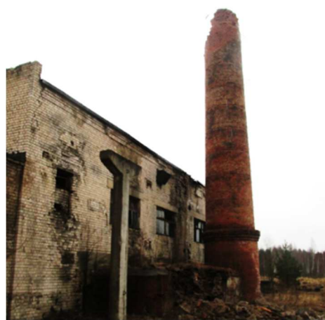
11.att. Izdemolēta un daļēji sabrukusi katlumājas ēka un dūmenis
