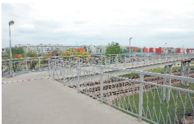
● Rekonstruētais gājēju tilts Jaunajā Forštātē
