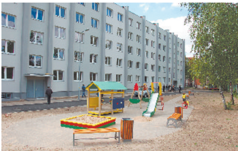
● Uzbūvētā pašvaldības māja Šaurā ielā 24
