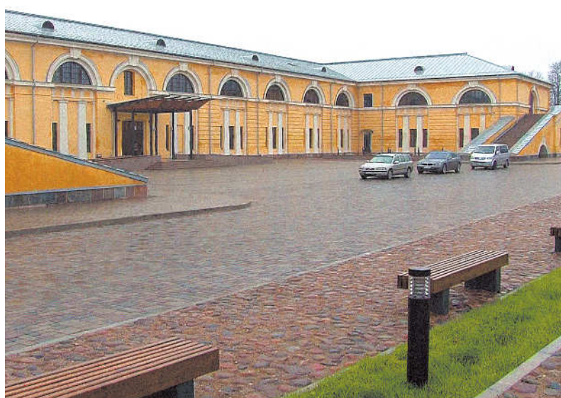
● Artilērijas Arsenāla ēkas rekonstrukcija
