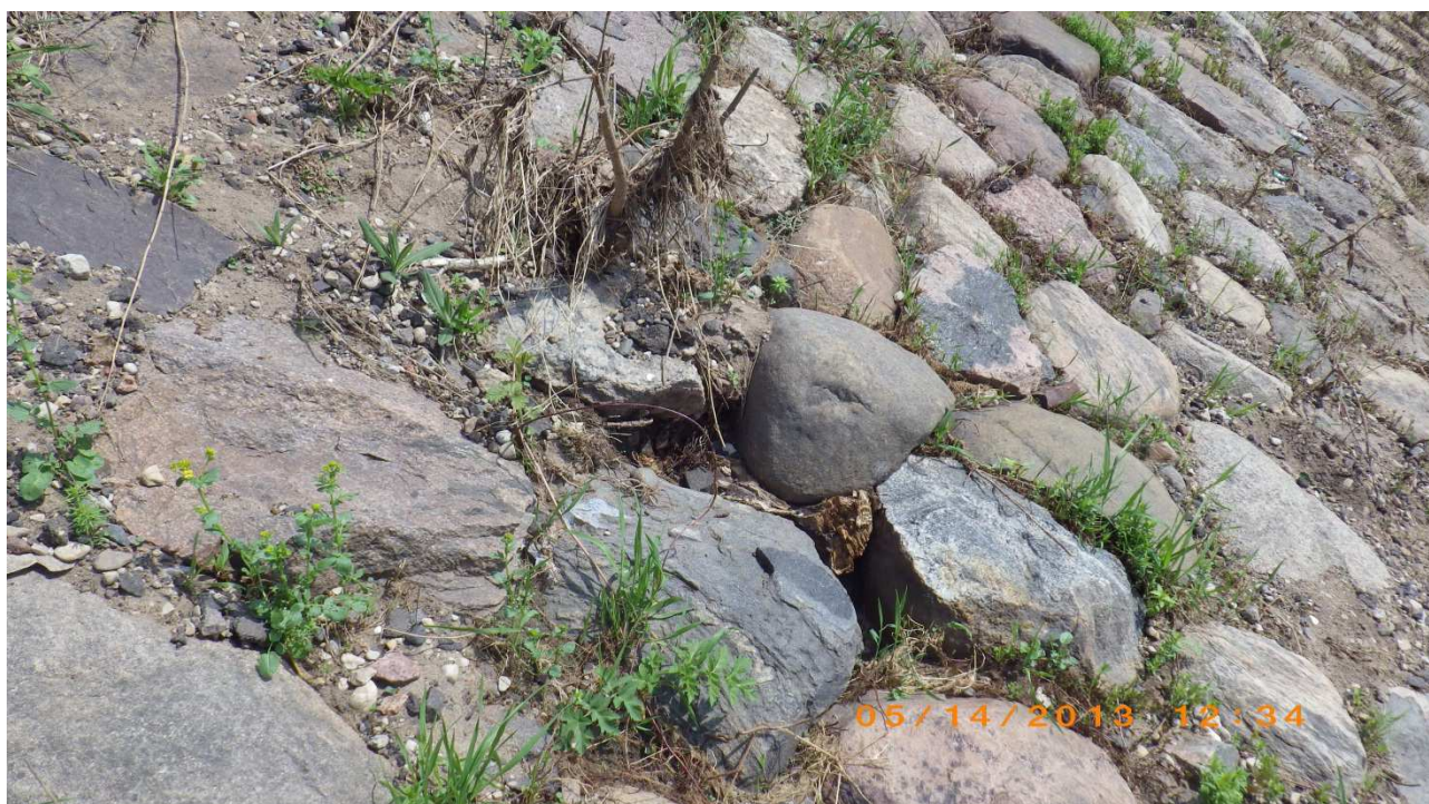
2. att. Krūmu saknes esošajā dambja nogāzes nostiprinājuma konstrukcijā
