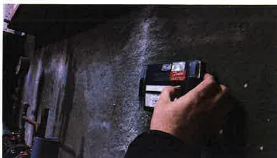
Piebūvē esošais siltummezgls ar siltumenerģijas skaitītāju
