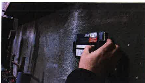
Piebūvē esošais siltummezgls ar siltumenerģijas skaitītāju
