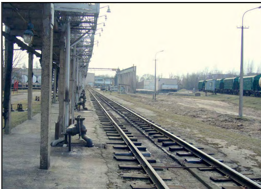
1.1. foto. Vienpusējā dzelzceļa cisternu noliešanas estakāde
