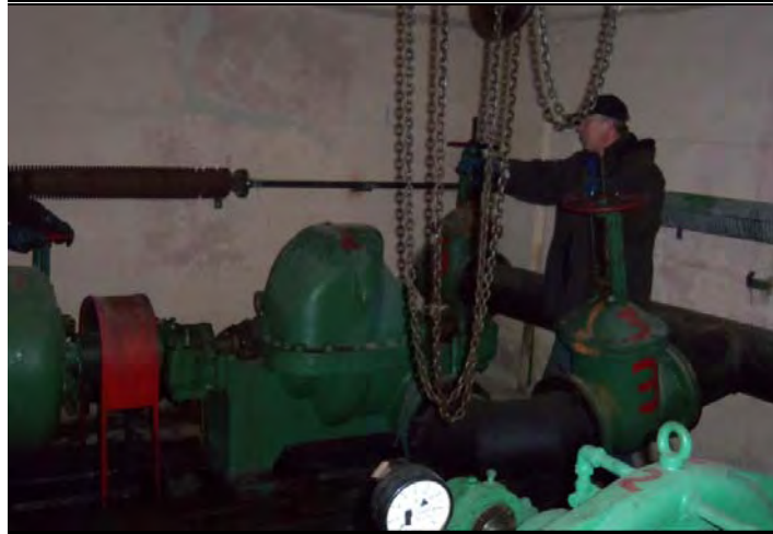
1.6., 1.7.foto. Ugunsdzēsības sūkņu stacija
