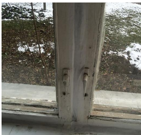
Vecais logs ar koka rāmi. Ir veikta rāmja blīvēšana un rāmja aizlīmēšana
