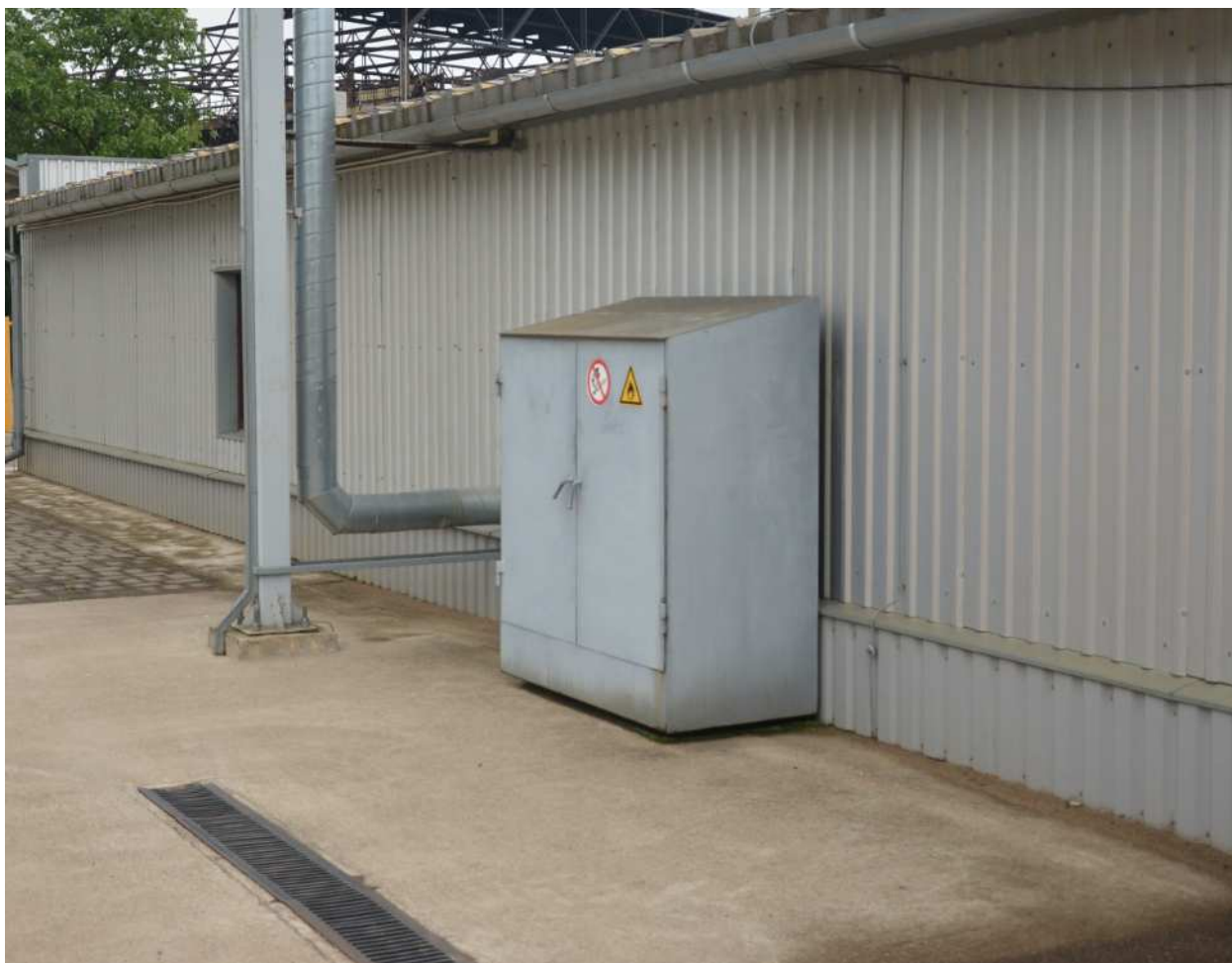
2.5. attēls. Autocisternu noliešanas vieta
