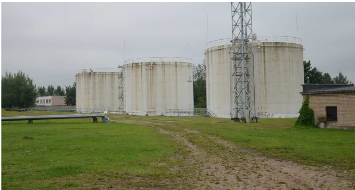
2.4. attēls. Vertikālo rezervuāru parks
