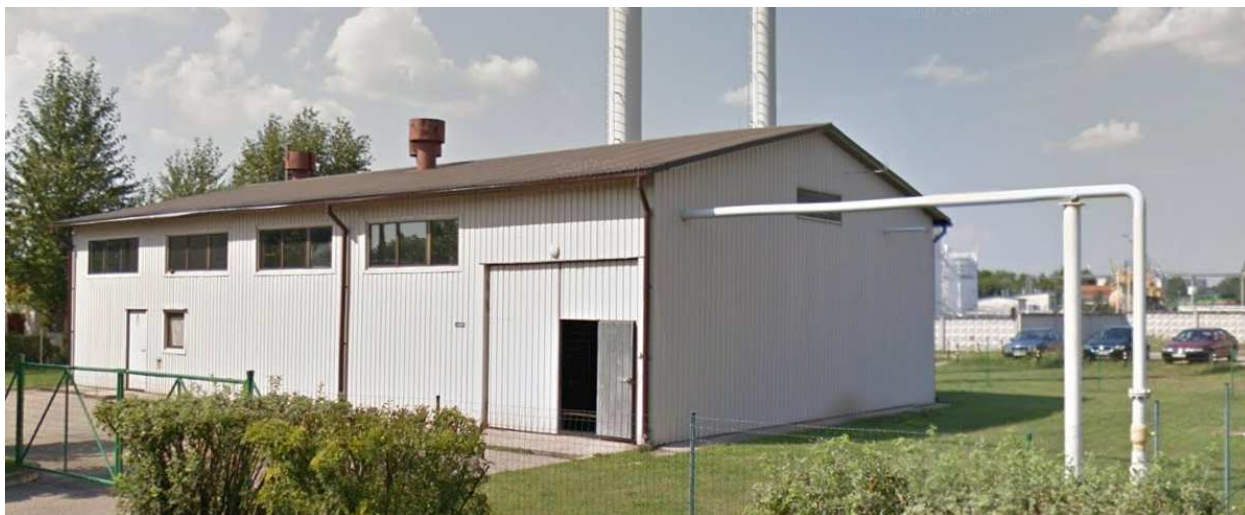
3.9.attēls. Katlu māja
