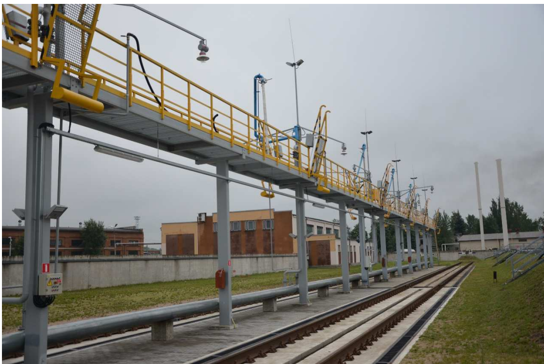
2.2. attēls. Dzelzceļa cisternu noliešanas estakāde
