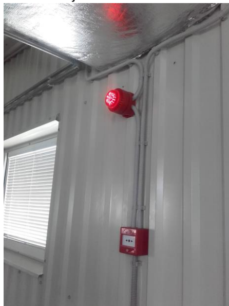
Att. 6.8. Iekšēja sirēna AH-03127S un rokas trauksmes poga FP/3RD
