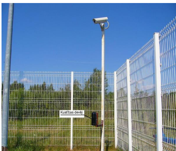
Att. 6.5. Videokameras un kustības devēja novietojums
