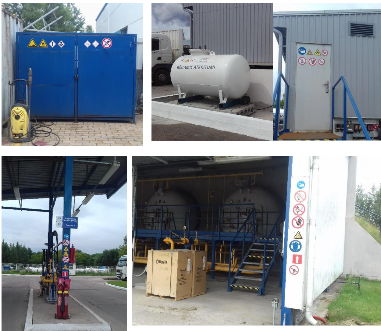
5.7 attēls Drošības zīmju pielietošana SIA “INTERGAZ” terminalā
