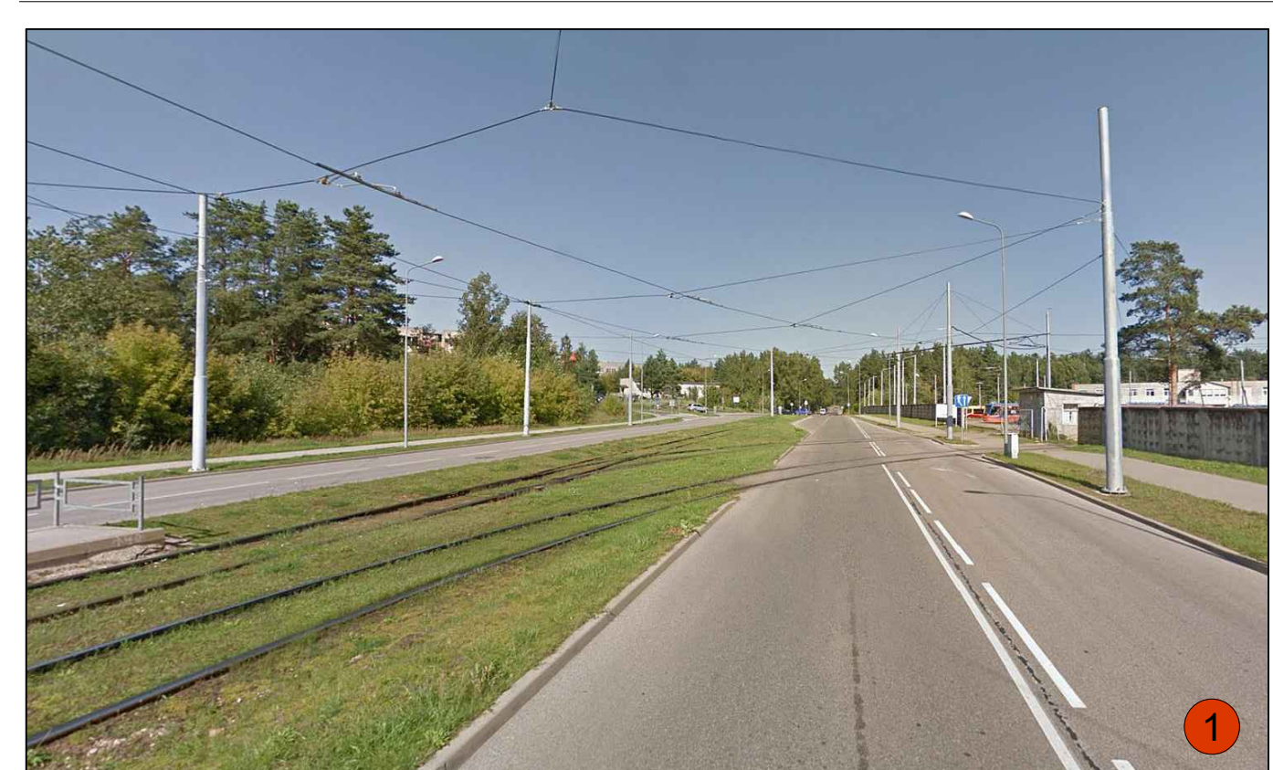
Jātņieku iela pie depo. Sliežu ceļš šķērso brauktuvi
