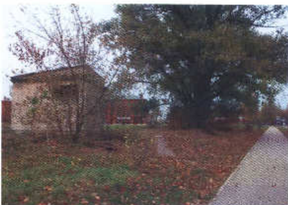
6.att. Skats uz esošām būvēm lokālplānojuma teritorijā
